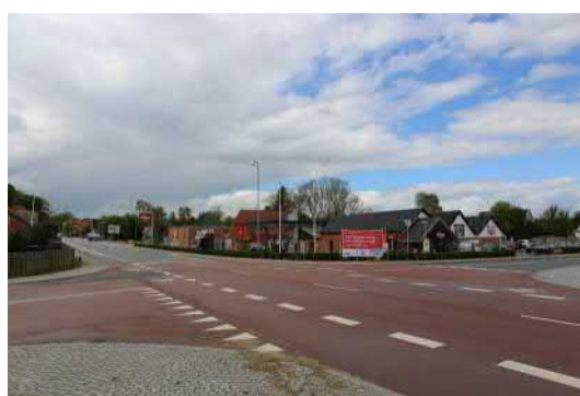
1. Trafikdæmping ved at hæve fladen og indfarve asfalt. Superbrugsen og tankstation på hjørnet
