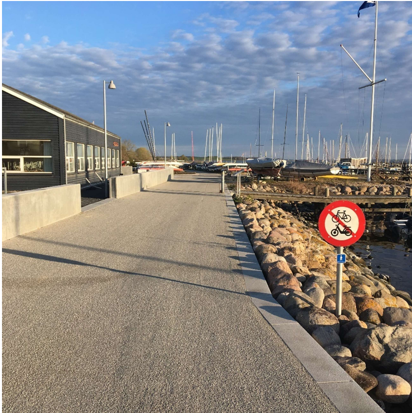
Fast mur med åbninger til mobil sikring, strækning 7, foto fra Roskilde Havn, Foto: WSP
