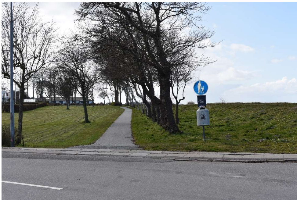
Foto: Strækning 9, eks. parkareal og dige set mod vest (Foto WSP)
