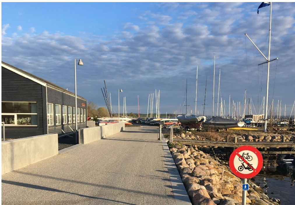
Figur 6 Eksempel på fast mur med mobile sikringsløsninger. Foto fra Roskilde Havn, WSP.
