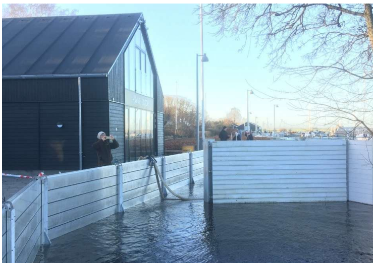
Figur 7 Figur viser eksempel på mobil sikring mod stormflod. Roskilde januar 2022, WSP.
