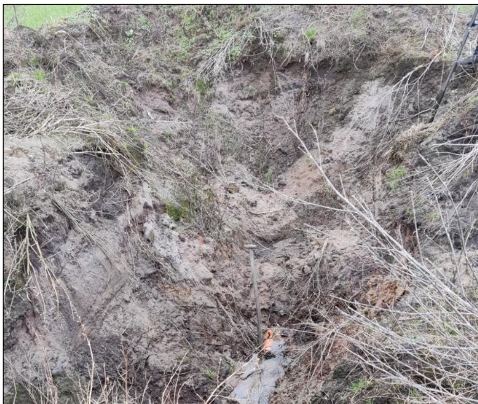
Figur 12: Frigravning i afvandingssystem 11.
