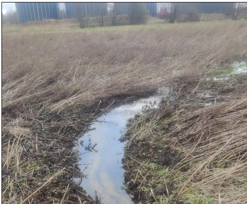
Figur 10: Diffust grøfteforløb i afvandingssystem 5.
