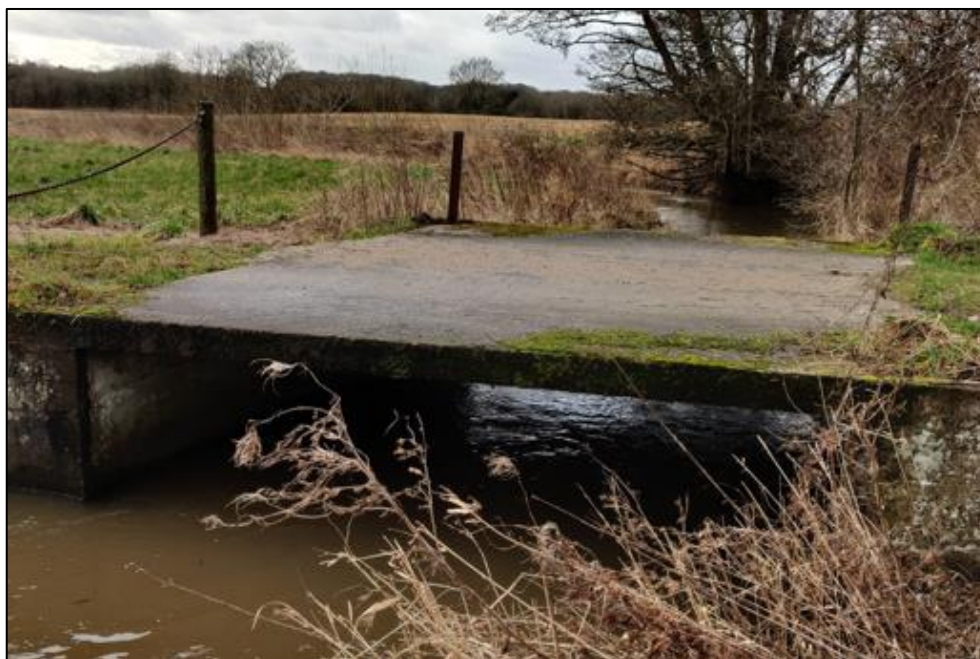
Figur 17: Betonbro i st. 15.370 m.
