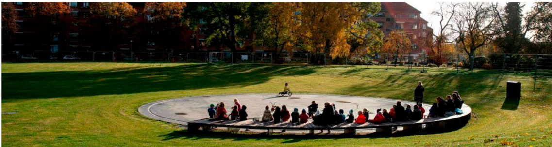
Figur 6, Nedgravet scene/legeplads, der også fungerer som vandopsamlingssted ved oversvømmelser.
