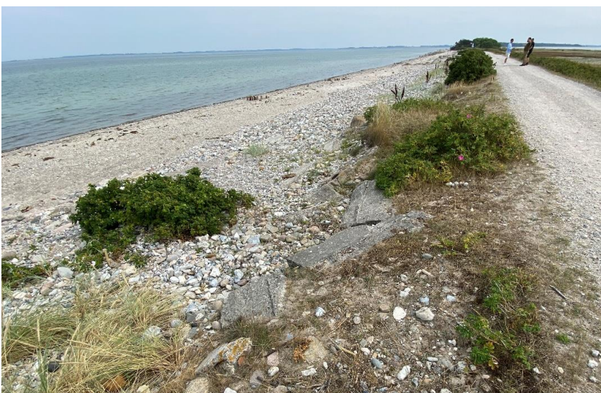
Figur 5-2: Rynket rose og rester af betonblokke på skråningen ved oddens nordside. Billeder taget under besigtigelse d. 17/8-2022.
