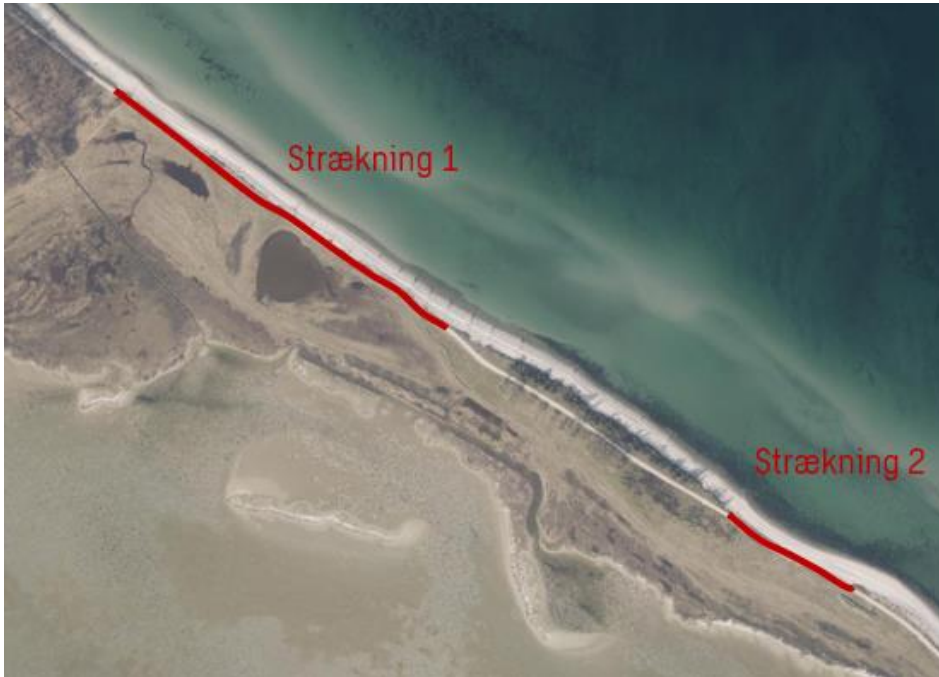
Figur 1-2: Strækning 1 og 2 hvor der ønskes beskyttelse af adgangsvejen mod erosion (Spatial Suite, ortofoto gældende for 2021-03-31).
