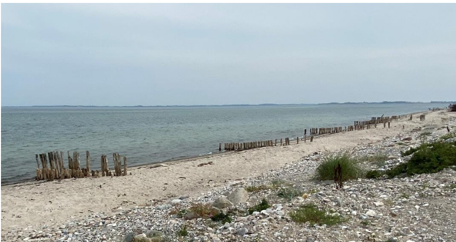
Figur 5-5: Eksempel på eksisterende træhøfder. Billeder taget under besigtigelse d. 17/8-2022.
