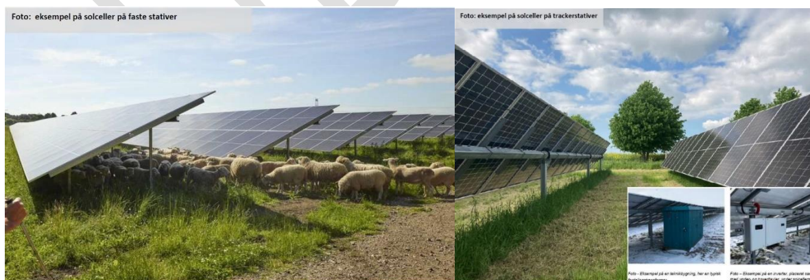
Figur 3.3: Paneltyperne faste paneler til venstre og trackerpaneler til højre.
