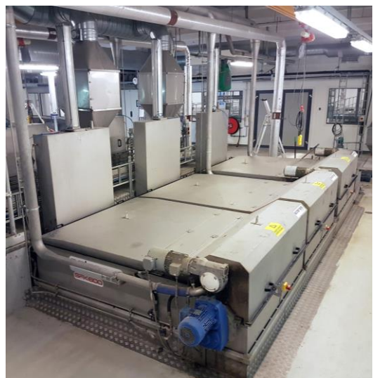
Figur 17 Eksempel på installation af et tromlefilter, Mølleåværket (venstre) og Salsnes filtre, Saulekilen Renseanlæg
