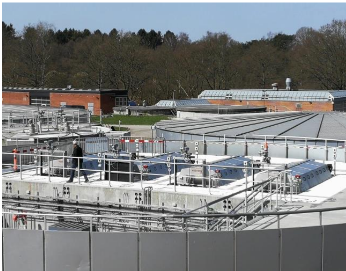
Figur 17 Eksempel på installation af et tromlefilter, Mølleåværket (venstre) og Salsnes filtre, Saulekilen Renseanlæg
