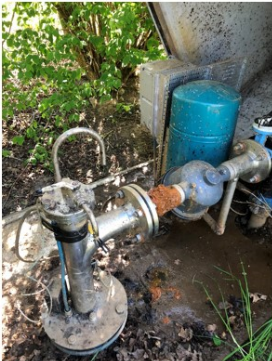
Figur 1: Billeder af utætheder fra boring DGU nr. 136.1139
