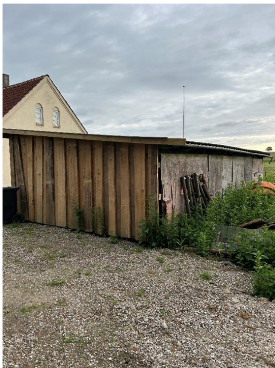
Figur 4 Billede af eksisterende garage. 'Lille løsdrift' ønskes opført på bagsiden
