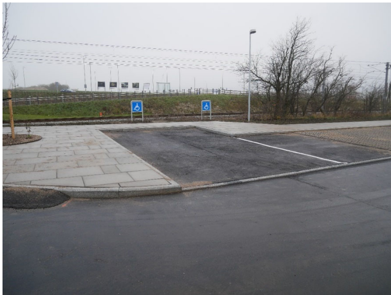
Figur 10.3 Eksempel på 8 m dyb kassebilsparkeringsplads, hvor den ekstra plads er opnået ved at lave pladsen dybere. Der mangler en hensigtsmæssigt placeret niveaufri adgang til gangareal (Vinge station, Nordsjælland)
