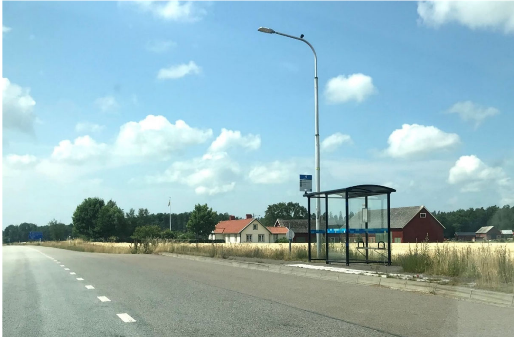
Figur 9.2 Eksempel fra Sverige på stoppested i åbent land med lokal kantsten, perron og læskærm.
