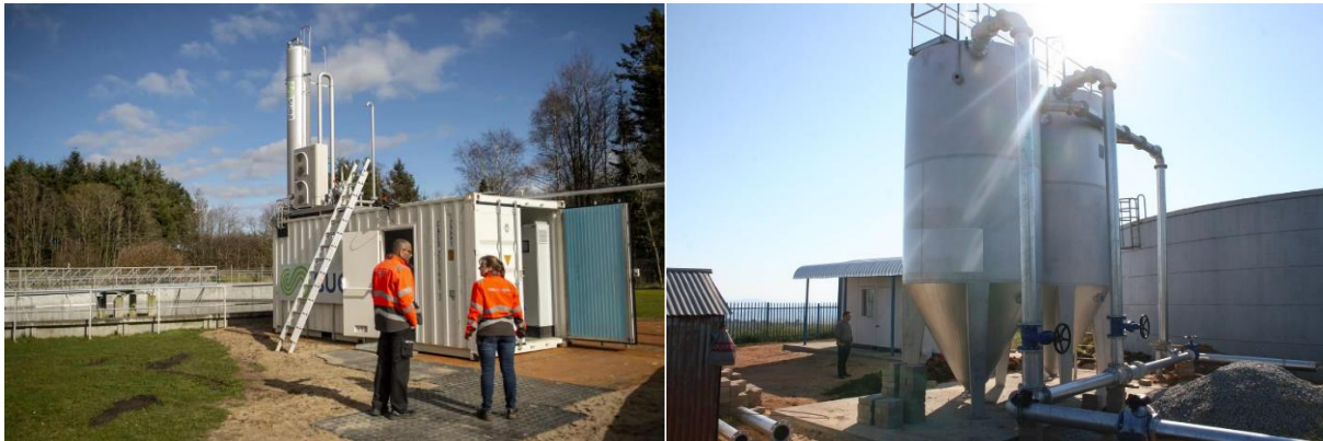
Figur 2 TV: SUEZ ozon pilotanlæg ved Brædstrup Renseanlæg; TH: Eksempel på teknisk løsning til sandfilter (DynaSand®)
