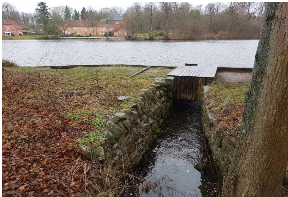
Figur 3-4 Ålekisten ved afløbet fra Langesø
