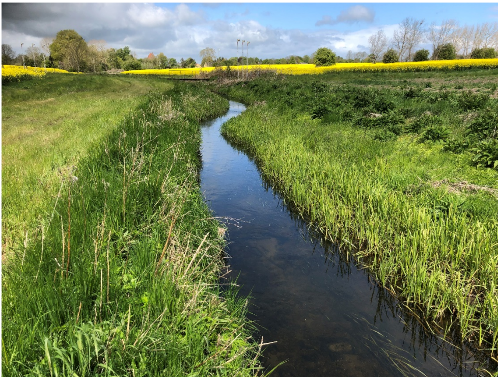
FIGUR 2: EKSEMPEL PÅ BRINKFØDDER LANGS LUNDE Å'S VENSTRE BRINK OMKRING ST. 6.640 M SET FRA NEDSTRØMS RETNING.
