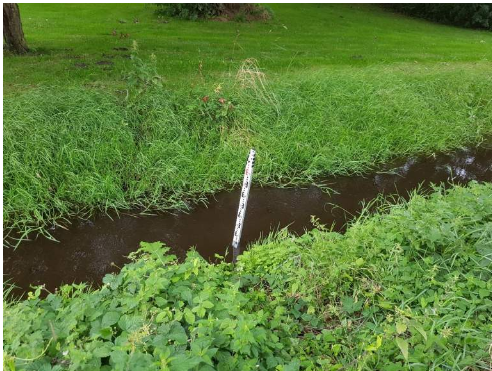
Figur 4-3 Bundudskiftning foreslås på denne strækning nedstrøms Havrekrogsvej
