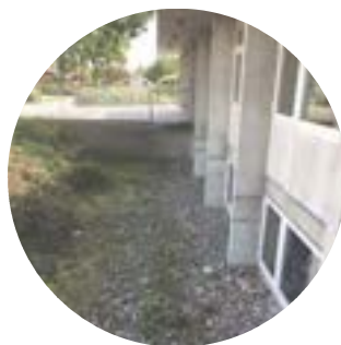
Facaden på blok E
