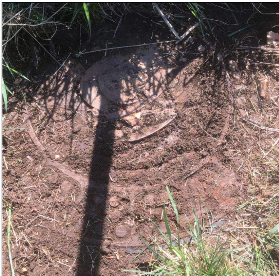
Figur 3: Brønddæksel lukket med gummipakning efter vandløbets udløb af undersøgelsesområdet.
