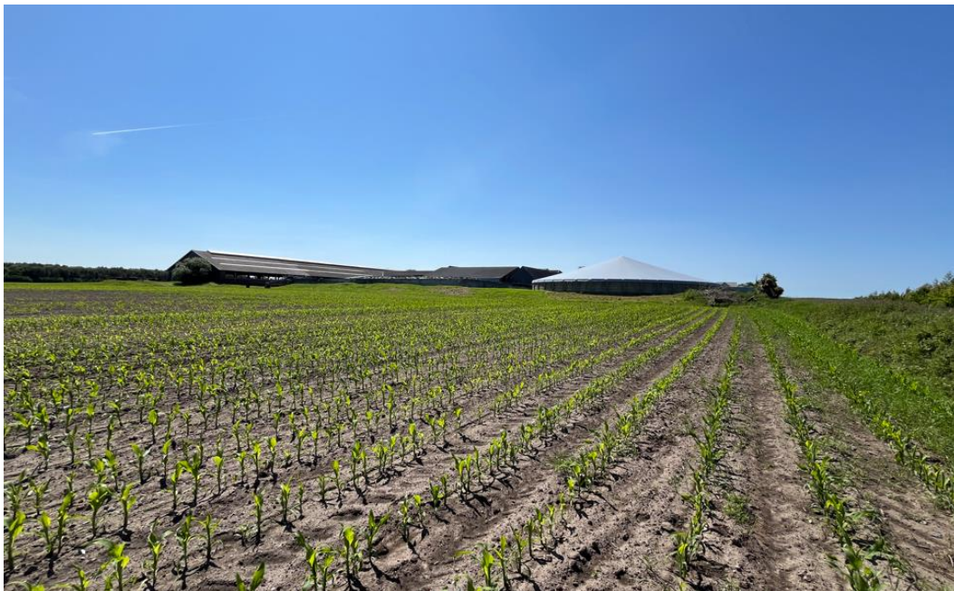
Foto 2: Gyllebeholderen set fra fra marken nord for ejendommen. Det er tanken til højre der overdækkes
