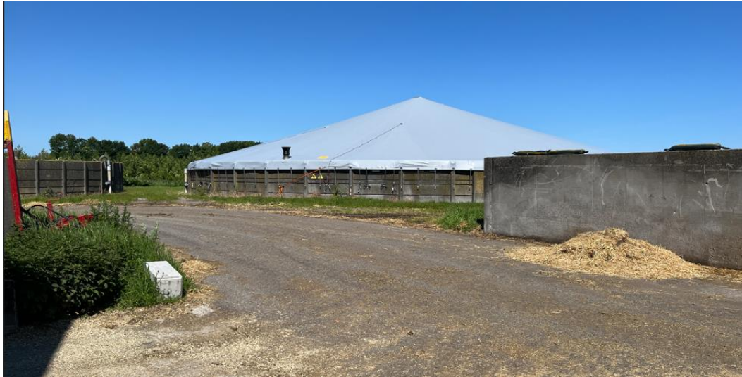
Foto 1: Gyllebeholder der overdækkes. Det er gyllebeholder til højre der er blevet overdækket.
