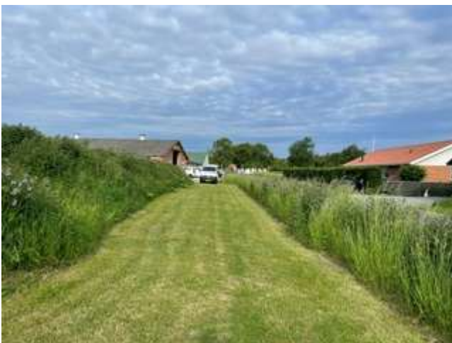
2. juni 2026 foto af vold mv. fra arealet syd for volden og mod vest, volden er til venstre
