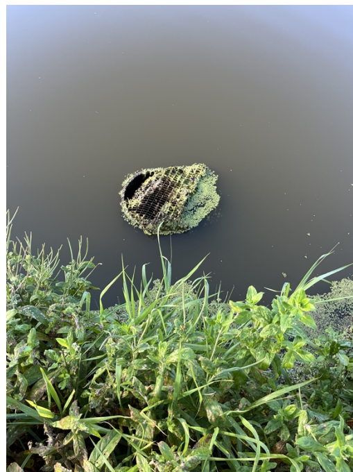
Figur 4: Det gamle overløbsrør ses på billedet. Det ses ligeledes på billedet at vandets sigtbarhed er dårlig og højst et par centimeter. Vandet fremstod mere grøntbrunt ved besigtigelsen end det fremgår på billedet. Der ses også en meget næringspræget brinkvegetation.
