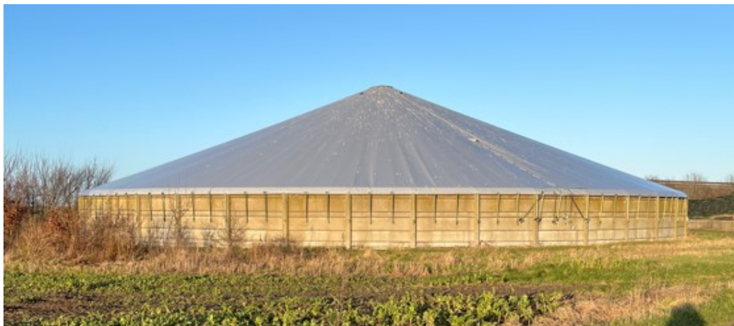
Foto 2: Tank ved plansilo
