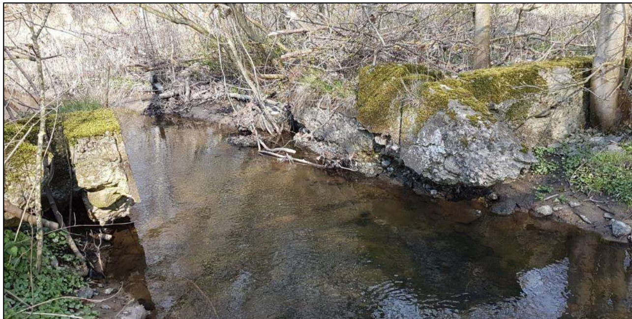
Figur 3: Tidligere engvandingsanlæg ved st. 2.475 m set opstrøms.
