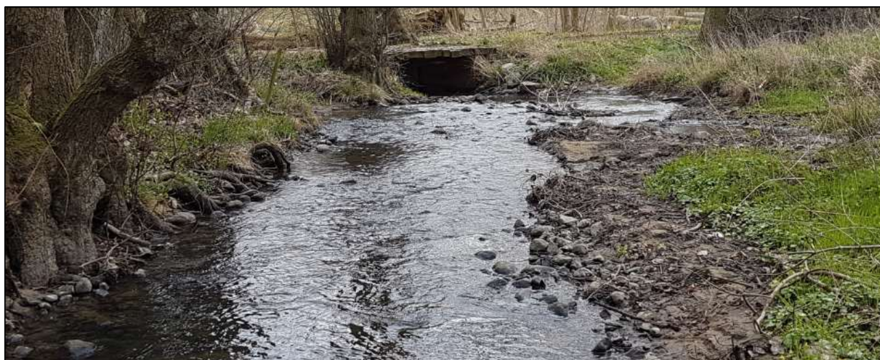
Figur 4: Nedstrøms engvandingsanlægget set medstrøms.
