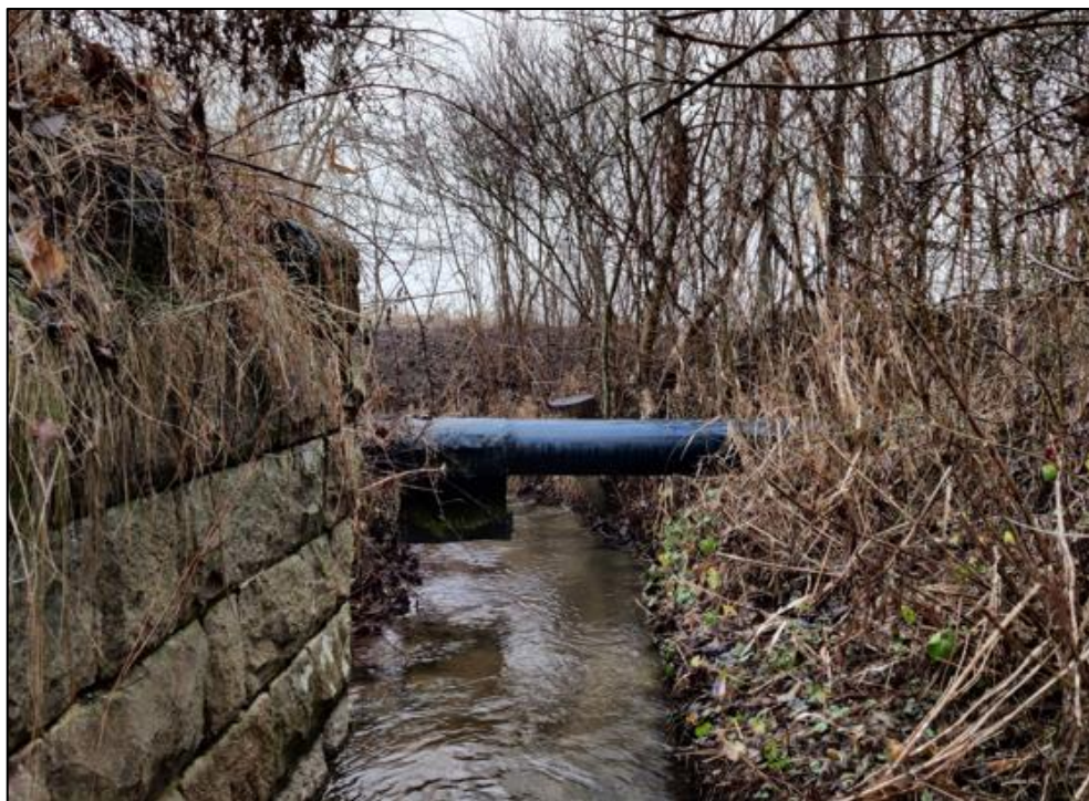
Figur 3: Krydsende gasledning ved st. 8.642 m.
