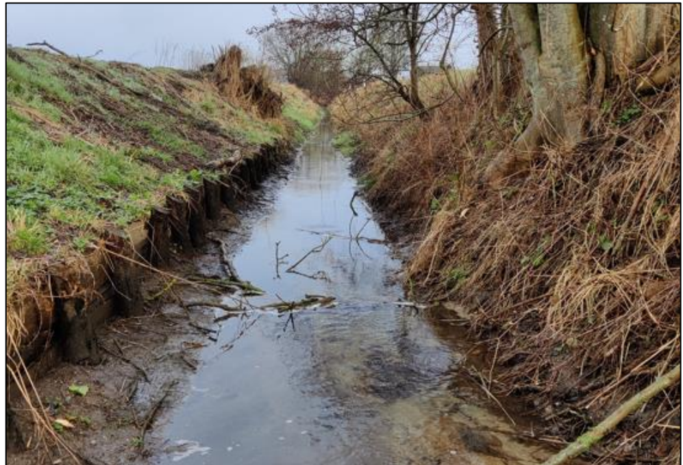
Figur 6: Vandløbet set i nordlig retning fra udløb under Uggerslev Mose.
