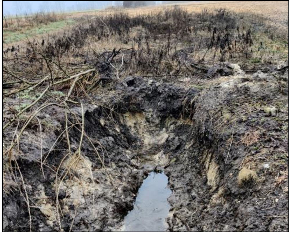
Figur 9: Frigravning af drænledning i afvandingsystem 1.
