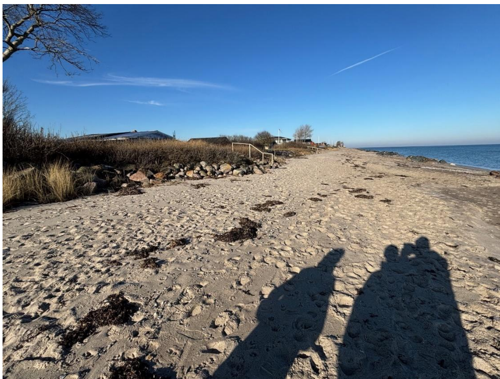
Figur 2-6 Stranden udfor matriklen. Kystskrænten er lav med spredt stenbeskyttelse og meget kraftig buskbevoksning. Gelænderet der ses i baggrunden er ved enden af stien på fløjdiget mellem Strøget 1 og 1A. Meget bred sandstrand da der løbende gennem årene foretages sandfodring.
