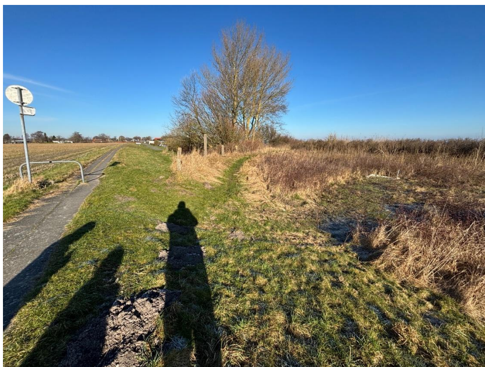
Figur 2-4 Diget bag sommerhusene i første række set mod nordvest. Foto er taget lige udfør grunden og fløjdiget med betonstolper ses foran træerne
