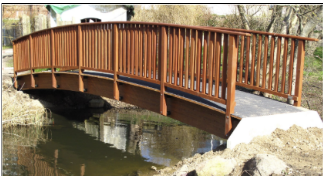
Figur 5: Skitsetegning af træbro i tværsnit og fotoeksempel på et træspang. Modtaget i mail af 6. juli 2026 fra Dennis Søndergård Thomsen, Rambøll Danmark A/S.
