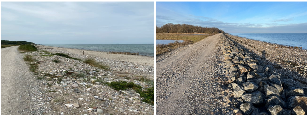
Figur 2: Venstre: Strækning 1 før etableringen af skråsikringen foran vejen (billede fra d. 17. august 2022) og den etablerede skråsikring på strækning 1 til højre (billede fra d. 16. januar 2024).
